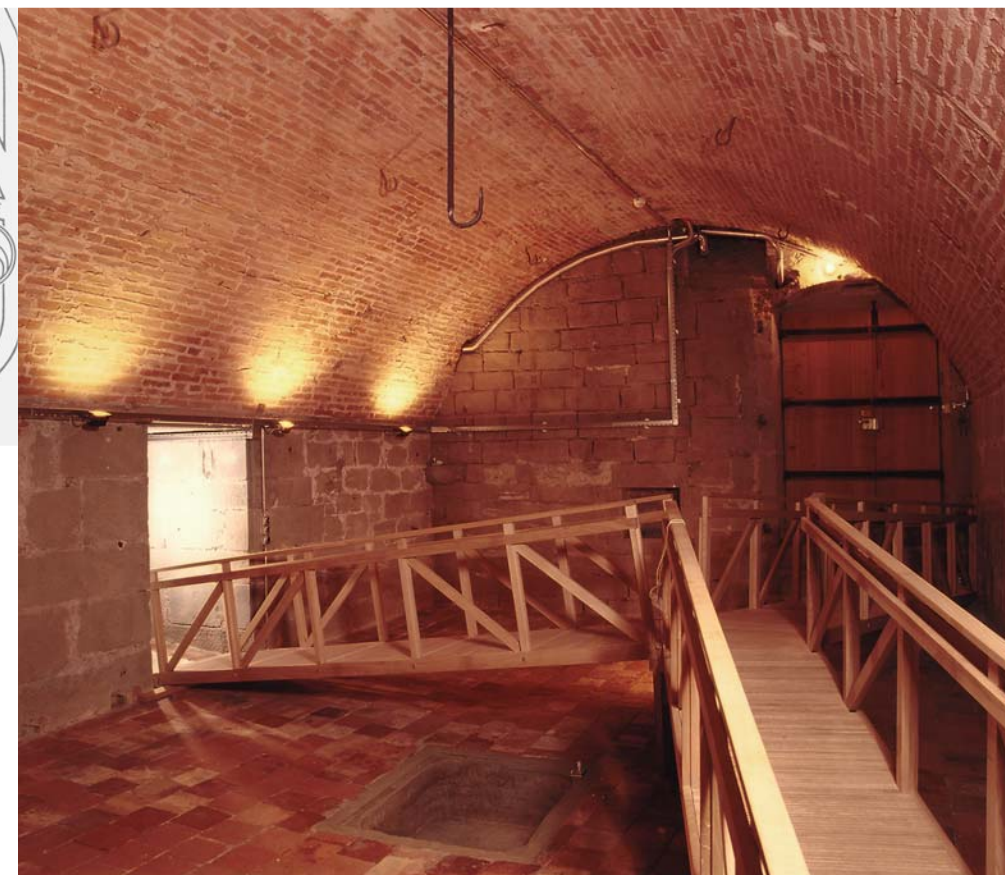
Steg im Gewölbekeller Ost
