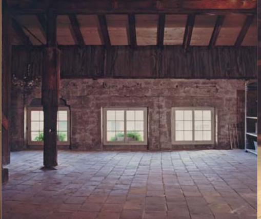
Estrich Nord mit Winde
